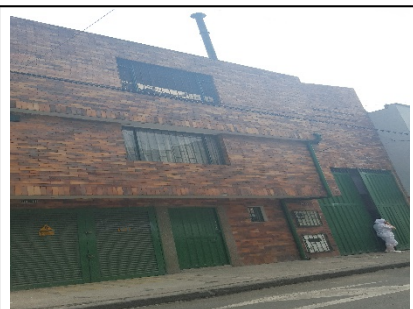
FOTO NO. 1 FACHADA DE LA SOCIEDAD
